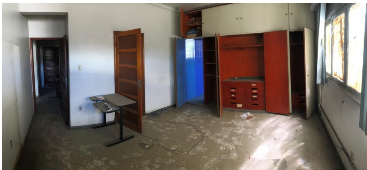
Foto 03: Interior do primeiro pavimento.
