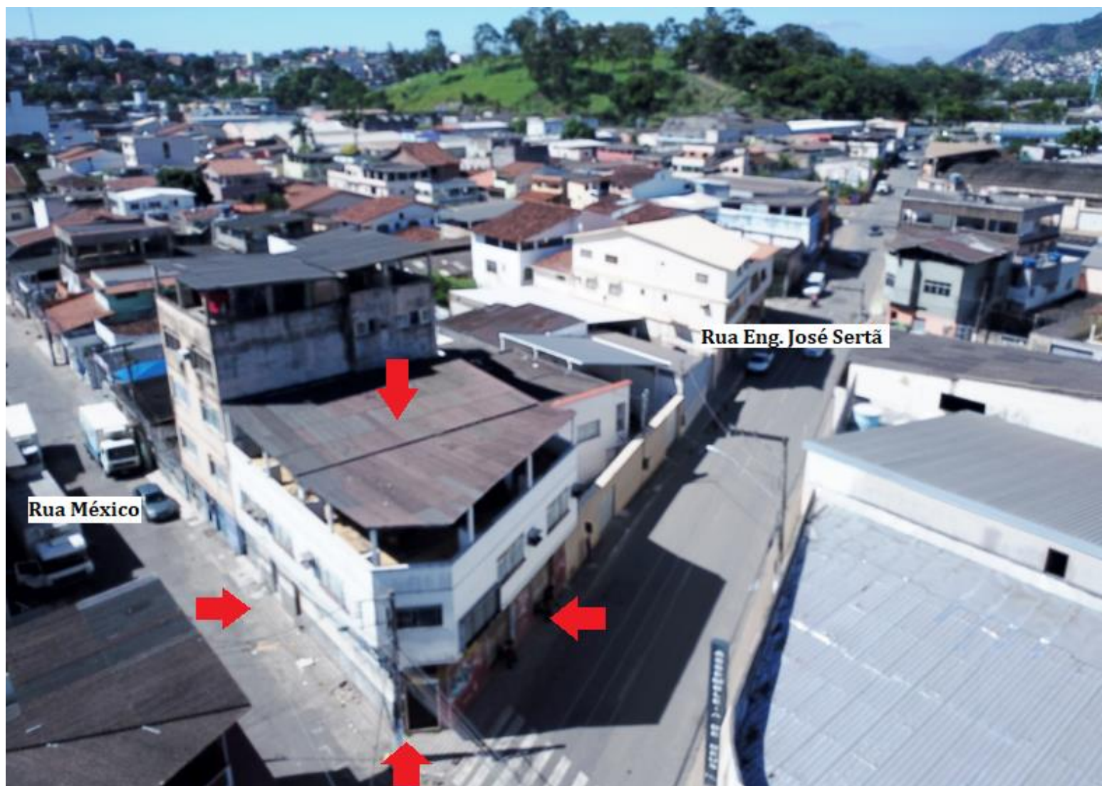
Foto 01: Fachada do imóvel.
