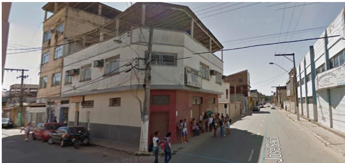
Foto 02: Fachada do imóvel.
