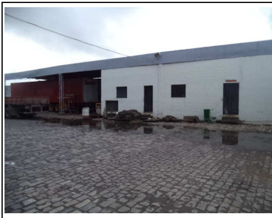
FOTO 15 – VISTA PARCIAL DE GALPÕES DE OFICINA E ALMOXARIFADO NO PÁTIO II.
