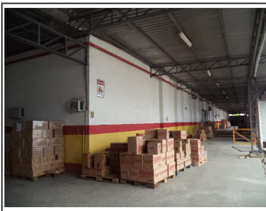
FOTO 4 – VISTA PARCIAL DOCAS DO GALPÃO PRINCIPAL.
