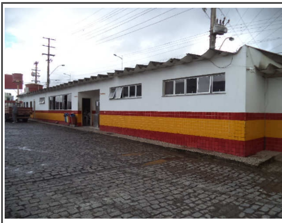
FOTO 9 – VISTA PARCIAL PRÉDIO AUXILIAR.
