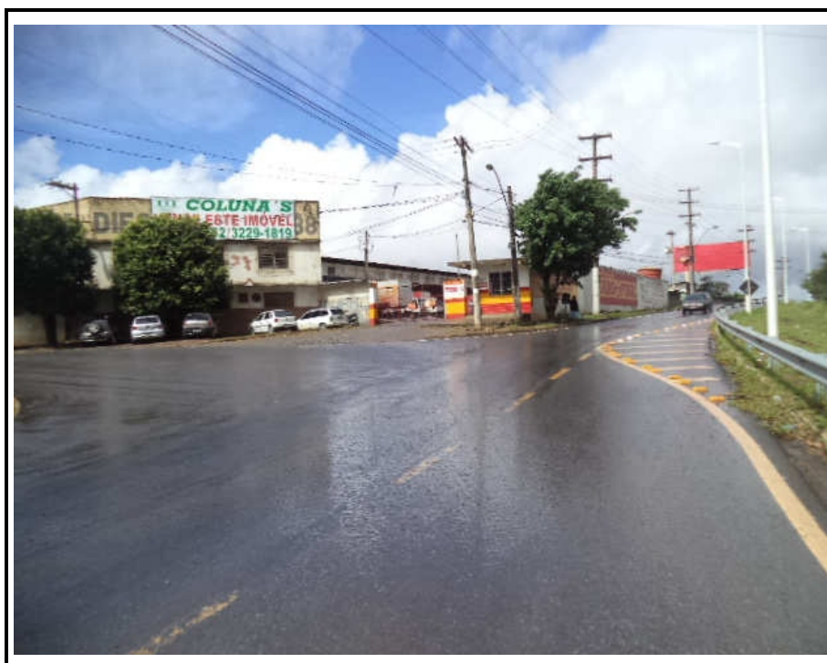
FOTO 16 – VISTA DA FACHADA/ ACESSO PRINCIPAL AO IMÓVEL ( PISTA LATERAL DA ROD DO CONTORNO/ BR 101).
