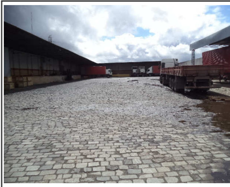
FOTO 13 – VISTA PARCIAL PÁTIO II
