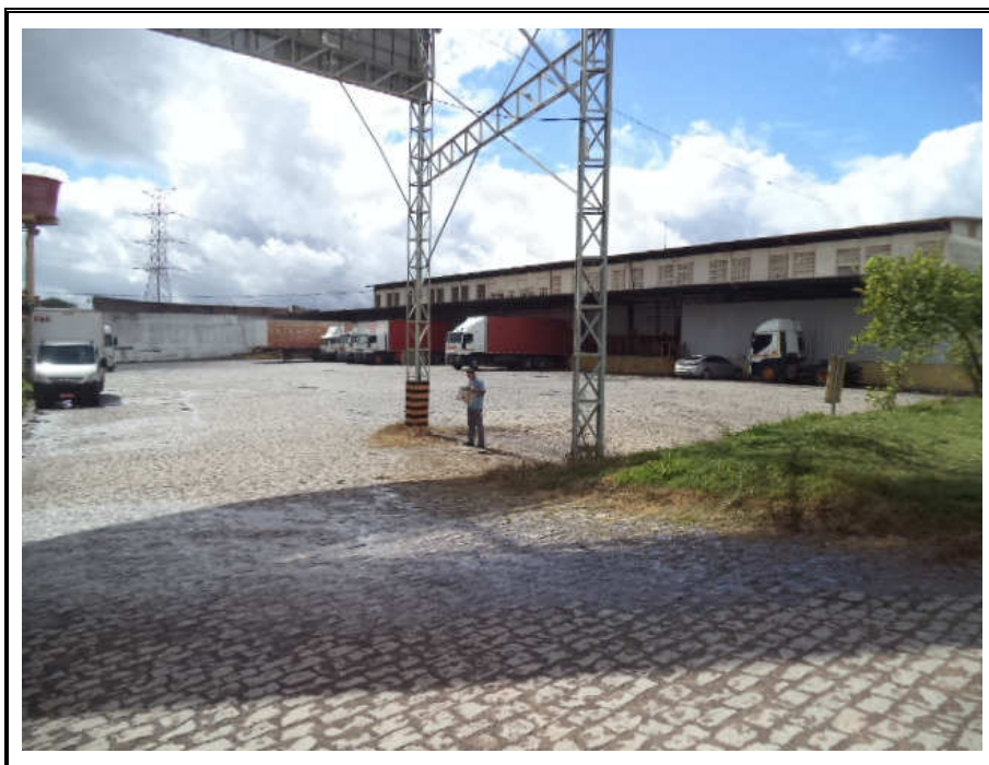
FOTO 2 - V VISTA INTERNA DO PATIO PRINCIPAL (FUNDOS - FRENTE).
