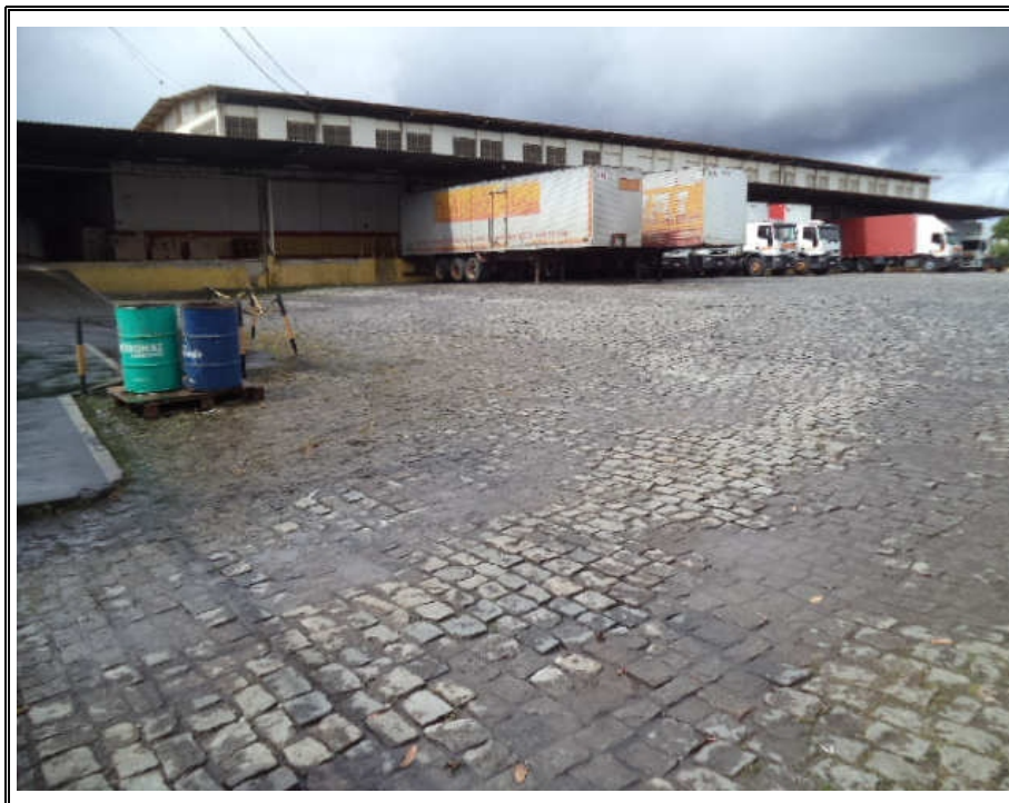
FOTO 3 – VISTA PARCIAL FACHADA DO GALPÃO PRINCIPAL.
