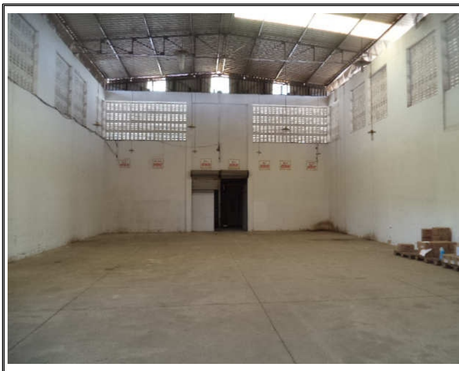
FOTO 5 – VISTA PARCIAL INTERIOR GALPÃO PRINCIPAL.
