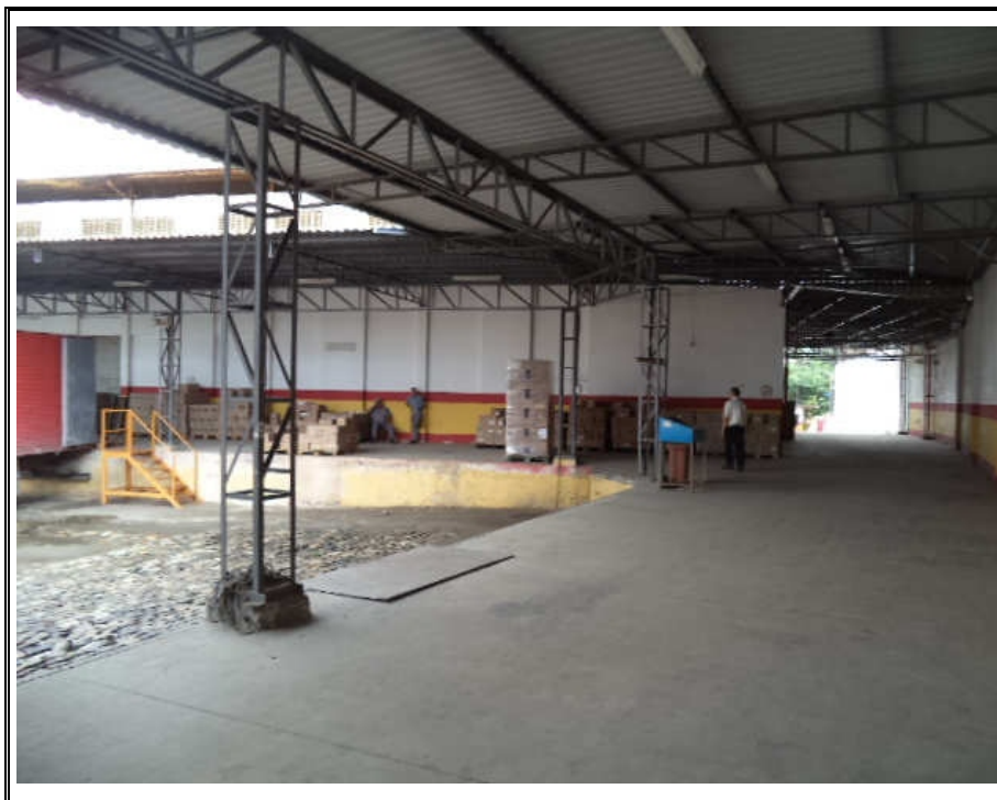
FOTO 14– VISTA PARCIAL DE DOCA/ ARMAZANAGEM NO PÁTIO II.
