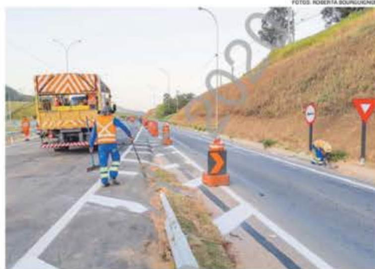
OBRAS na BR-101: trecho que será entregue fica entre o km 314 e o km 323
